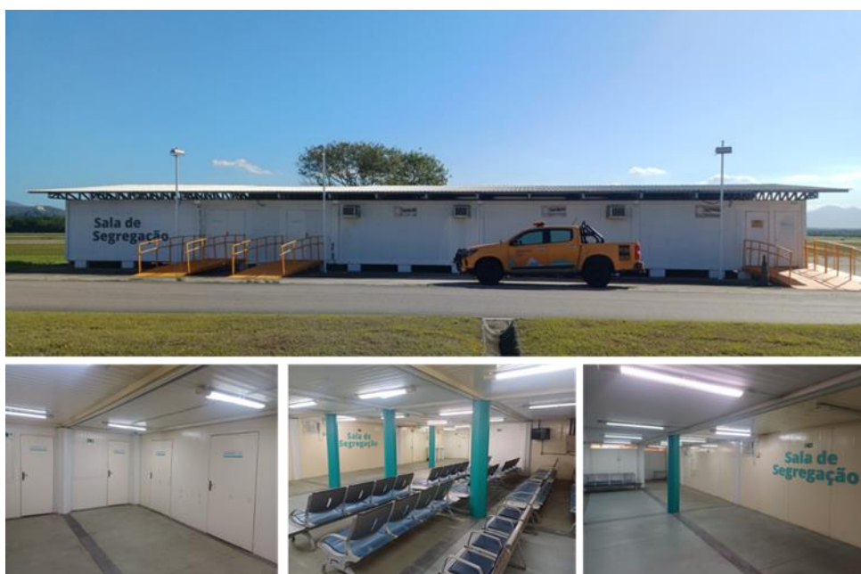
Figura 03 - Sala de Segregação
